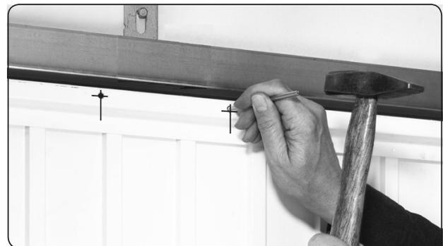
2. Schlagen Sie die Befestigungslöcher mit Hilfe des beiliegenden Schlagdorns in den Torrahmen.
