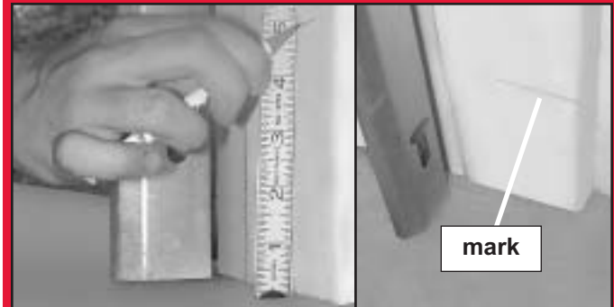
FIG. 3-1 Mark door frame.
