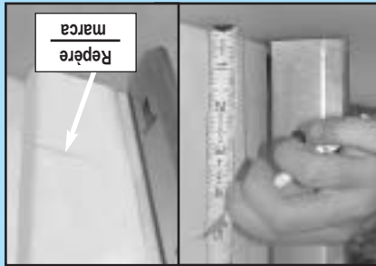
FIG. 3-1 Tracer les repères sur l'encadrement de la porte
