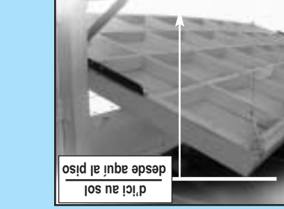
FIG. 2-1 Repérage du point le plus élevé de la course (à sections). Trouver le point le plus élevé de la course (à sections).
