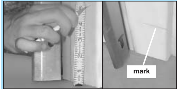
FIG. 3-1 Mark door frame.
