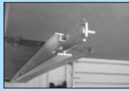
FIG. 1-4 Fixer la bride du rail. Acoplar la correa del rail.
